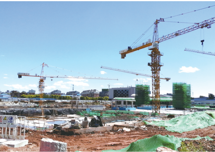
项目建设现场 城市晚报全媒体记者 刘佳雪 摄
