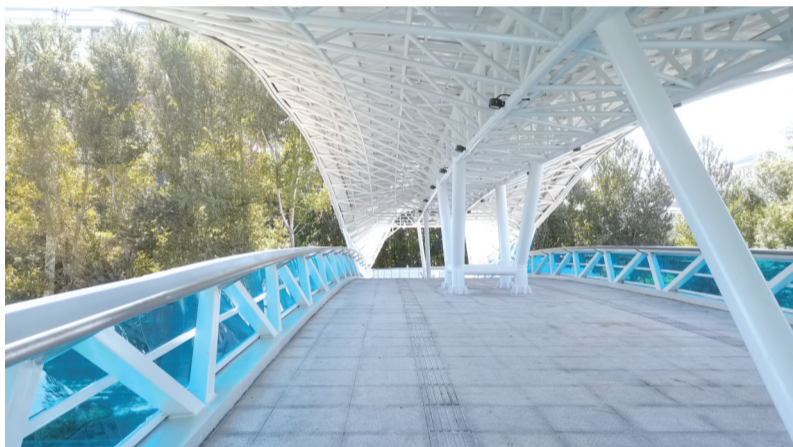
投入使用的过街天桥
