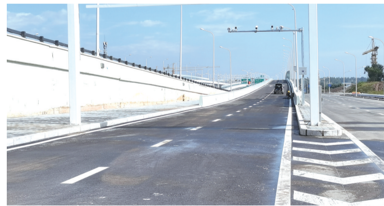
东部快速路南延长线工程剩余匝道交付使用 城市晚报全媒体记者 陆续 摄
