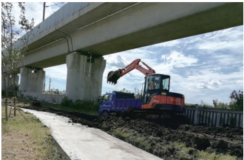
大型机械正在施工
