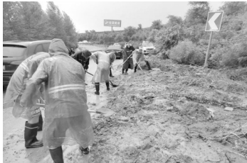
抢险人员开辟出一条临时通道
