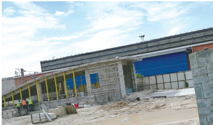
在建的芙蓉桥站地上进出口
