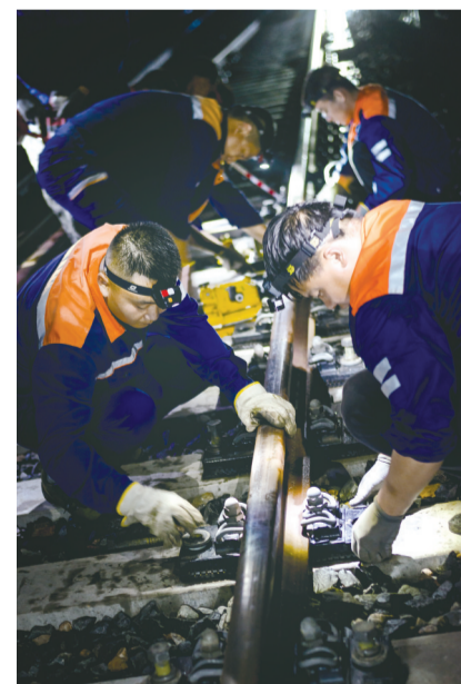
夜间作业检修中 本组图片 城市晚报全媒体记者 刘佳雪 摄
