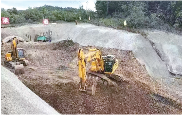
施工现场 长春站供图
