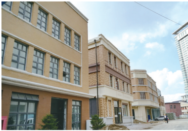
楼宇建筑修旧如旧
