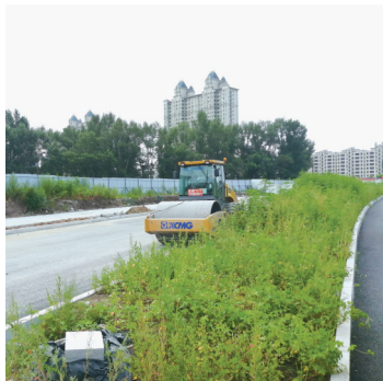
路面基础硬化基本完成
