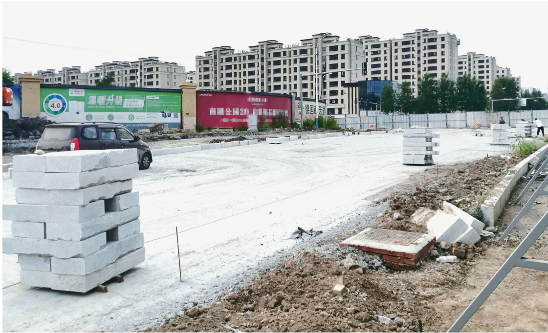
正在进行马路边石铺设 本组图片 城市晚报全媒体记者 刘佳雪 摄
