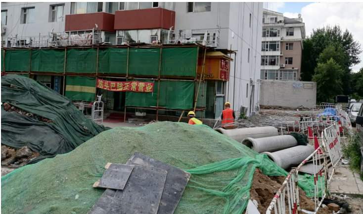
施工改造现场 城市晚报全媒体记者 刘佳雪 摄
