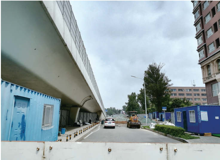
即将打通的“断头路” 本组图片 城市晚报全媒体记者 刘佳雪 摄
