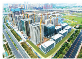
正在建设中的数字科技孵化基地项目
