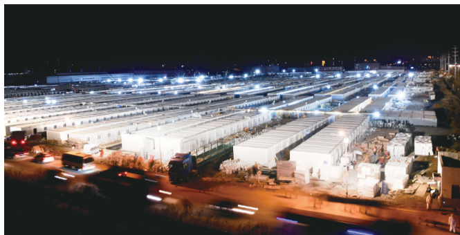
3月24日,吉林市一处工地,施工工人争分夺秒,通宵达旦抢建方舱医院。连日来,数千名工人昼夜不停,全力抢赶进度。
