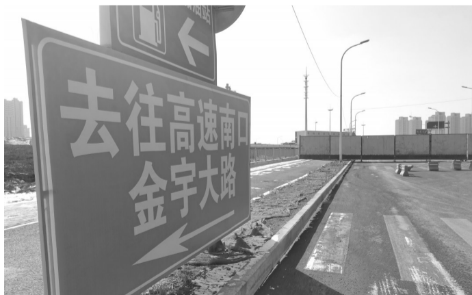
这条水泥路的封闭现场
