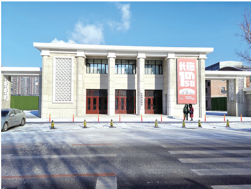
改造后的门楼
