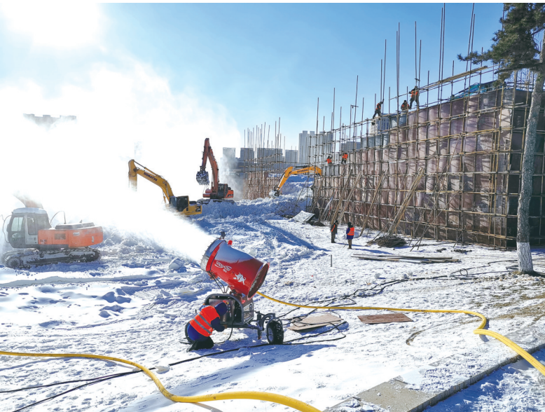
现场正在造雪
