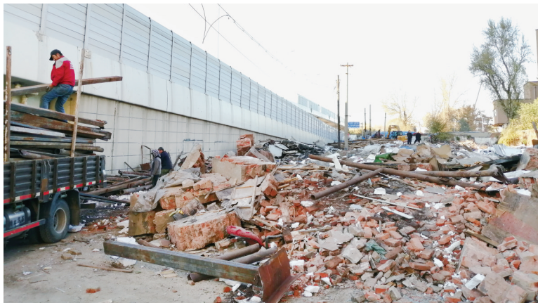
施工人员进行现场进行拆除
