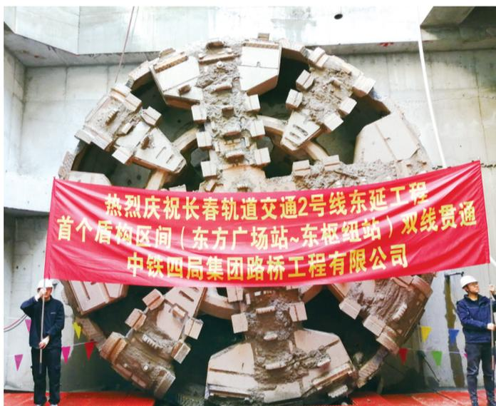
地层主要为粉质黏土、全风化泥岩,含水量较高,增加了出渣及推进难度。项目部精心筹划、科学组织,在掘进过程中24小时对地面进行监测,并保证同步注浆量,最终比原计划提前20天完成双线贯通。
