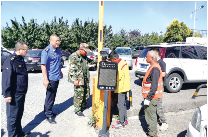
对停车场起降杆进行拆除
