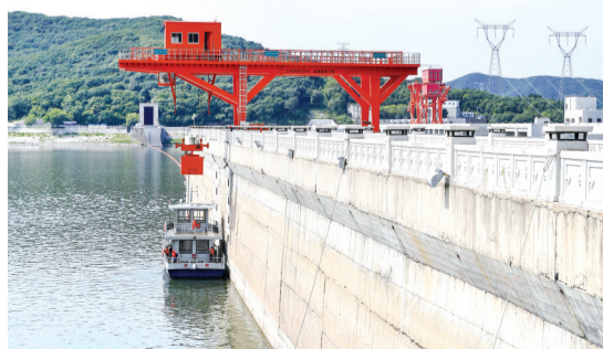
固定门机将运鱼箱放在运鱼船上,鱼类将被运至目标地点进行放流。
