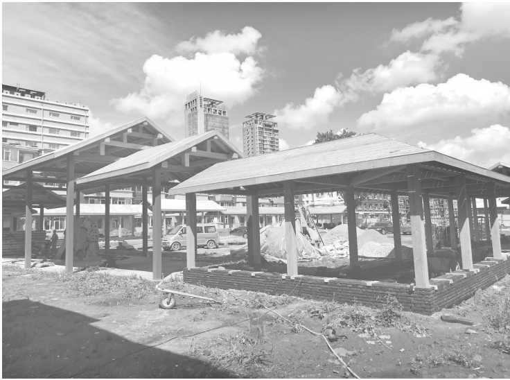
文化长廊正在建设
