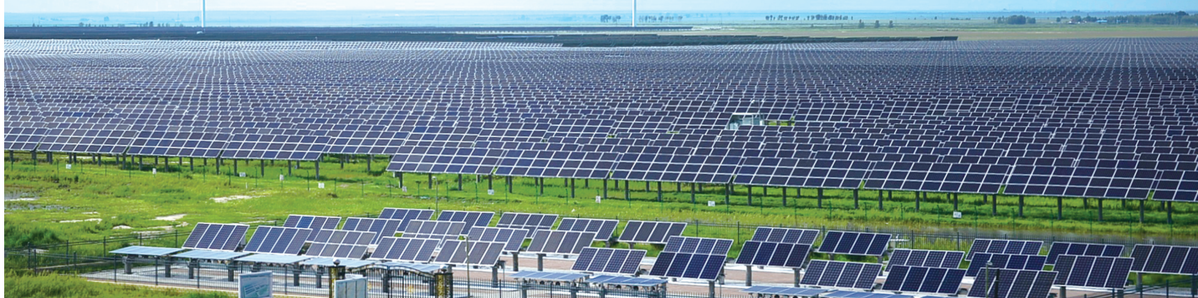
建设中的白城市镇赉县“陆上风光三峡”工程
