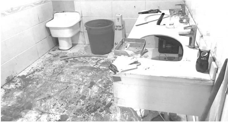
洗手池是漏的,洗手的水要用水桶来接
