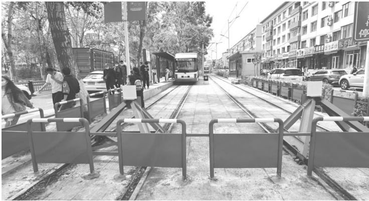
区域轨道已被封闭
