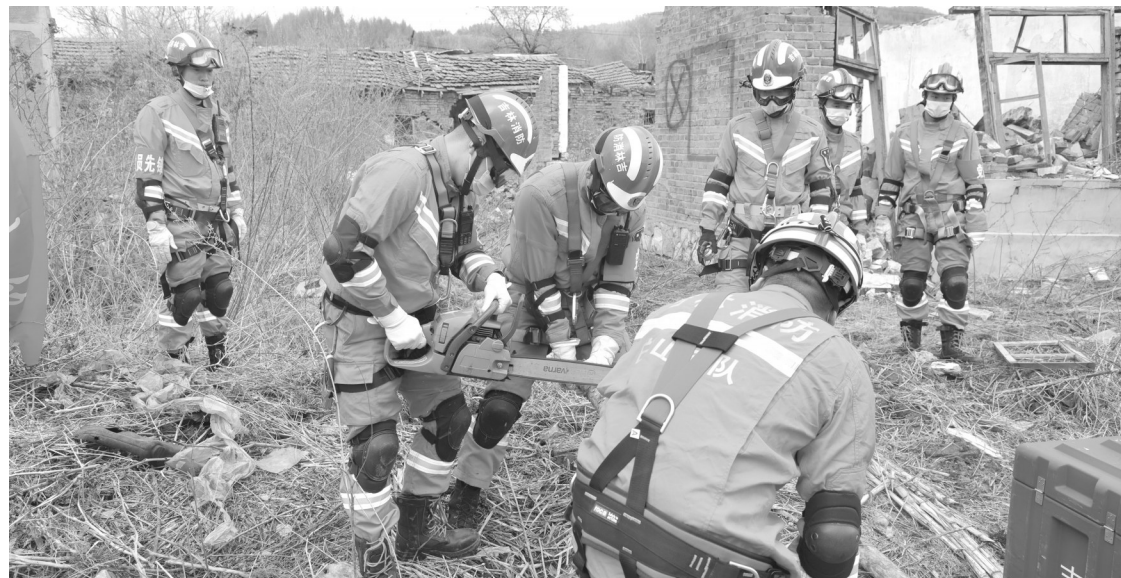
废墟搜索救援,危墙支撑保护,现场取材作业
