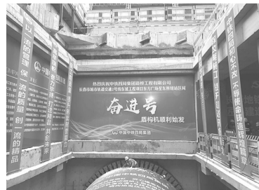
站至东方广场站盾构区间长1310米,盾构隧道内径为5.5米,管片壁厚0.35
