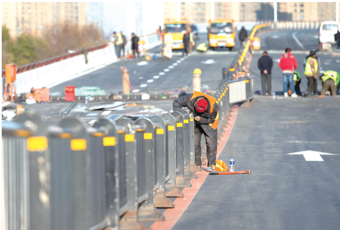
《长春惠工路立交桥西桥头 75 米拆除重建》续
