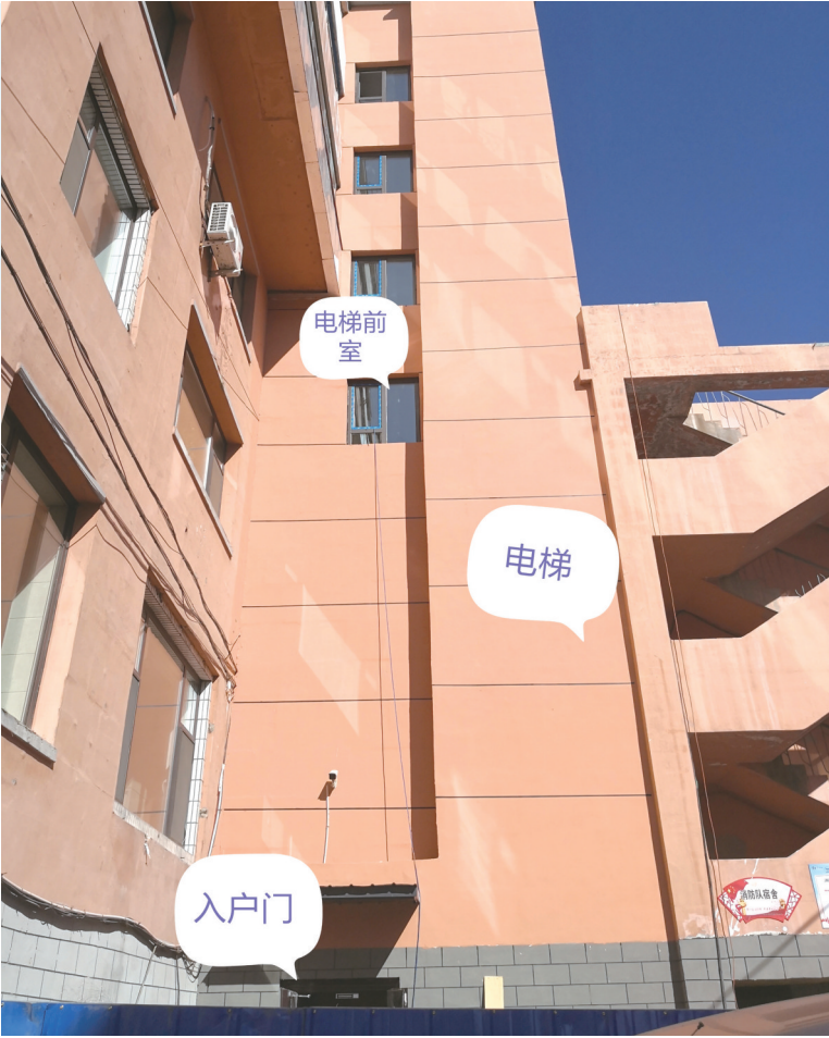
从外观上看,加装电梯已与整个居民楼融为一体
