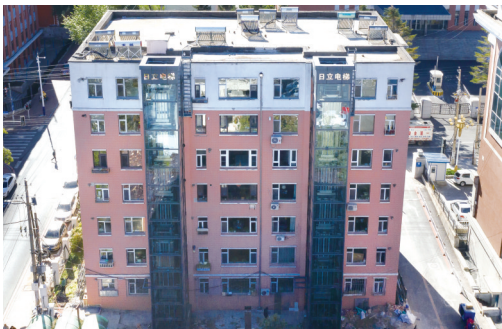
老干部宿舍电梯正在施工
