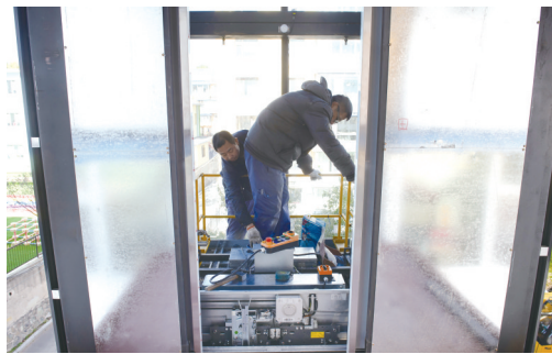
施工工人正在邮电小区安装电梯
