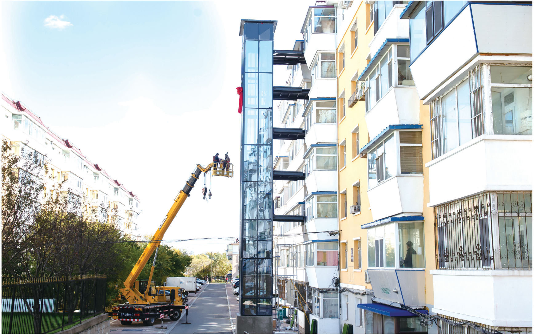
邮电小区15栋电梯正在施工
