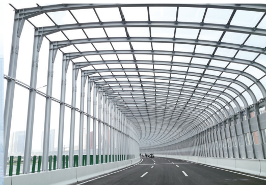
该工程创新性地采用半封闭式声屏障,有效降低了车辆昼夜通行产生的噪声影响
