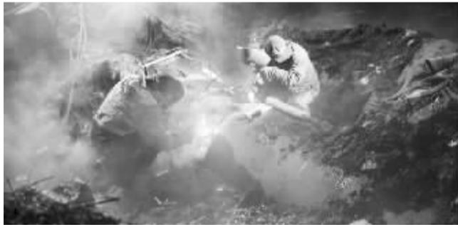
抢修师傅对漏点进行精密焊接
