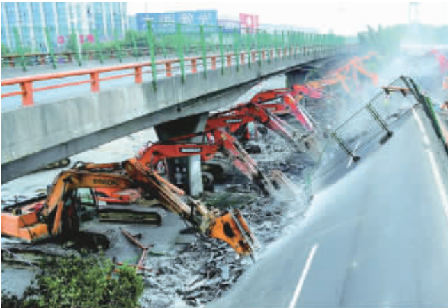
10月11日,在江苏无锡高架桥侧翻事故现场,施工机械在破拆侧翻高架桥段。
